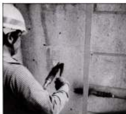
モルタル面への施工に
